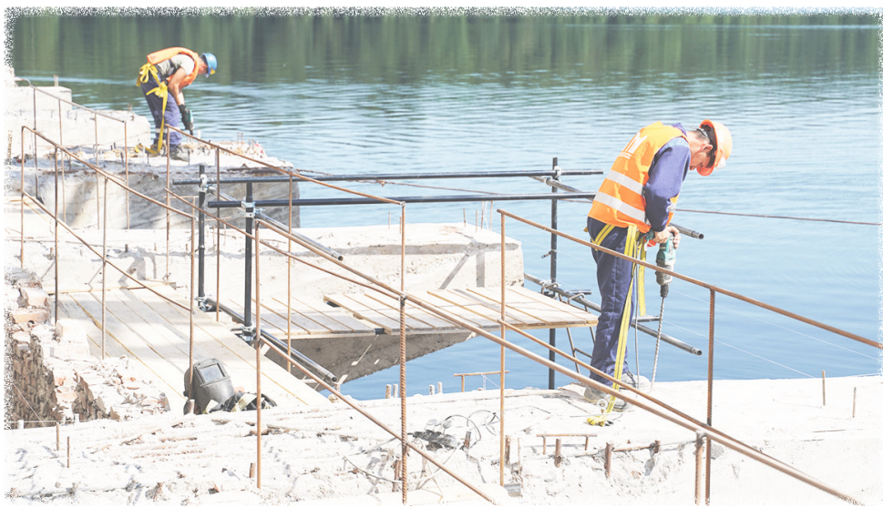
Работы по ремонту пролётных строений
